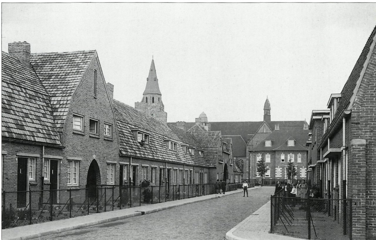
De Hermelijnstraat met rechts vooraan de Dasstraat en achteraan links de boogwoningen naar de Marterstraat. De foto geeft een goed beeld van de architectuur die Lambert de Vries voor R.K.Woningbouwvereniging De Hoop hanteerde. Achteraan staat het klooster aan de Prins Karelstraat met daarachter nog de St. Jozefkerk. De Hermelijnstraat verrees circa 1928. Fotograaf onbekend. (Collectie HIC Helmond)
